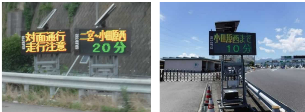
【迂回ルートへの分岐部手前の専用の道路交通情報板の所要時間表示イメージ（過年度設置状況）】
