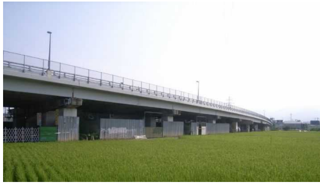
矢作高架橋の橋梁全景
