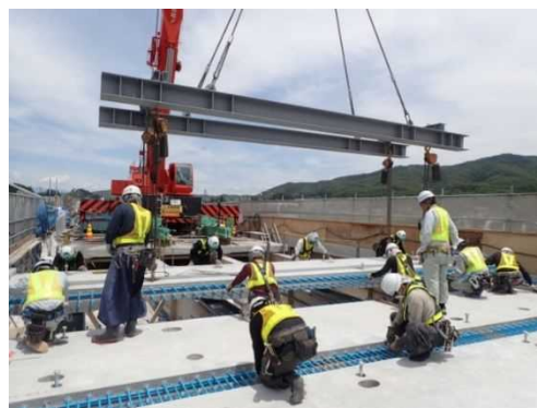
【プレキャストコンクリート床版の施工状況】
