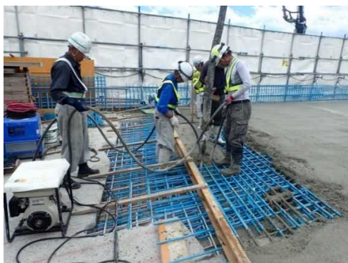
【現場打ち床版の施工状況】
