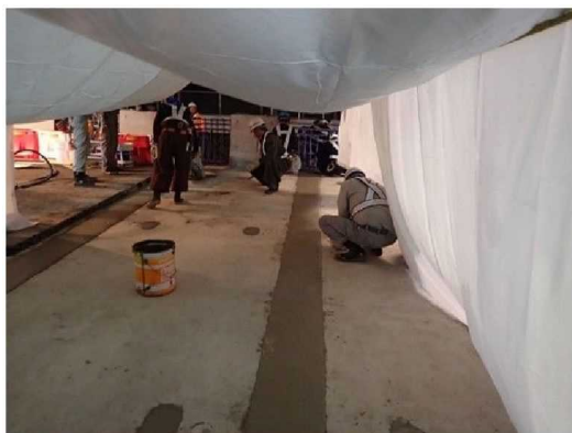
【雨天対策設備の設置状況】
