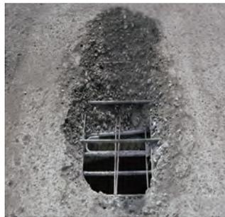
重量オーバーの車両が通行した為、床版(車両を直接支える部材)に穴が空いてしまった事例。
