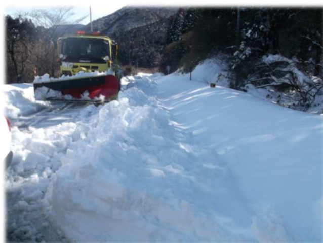
箱根新道での除雪作業
