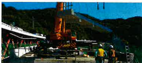
大型クレーンによる全断面床版取替
