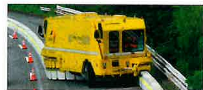
床版架設機による分割した床版取替
