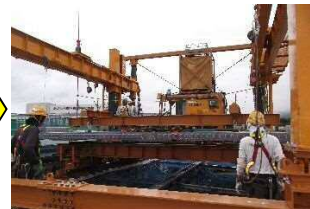
新しい床版を設置
