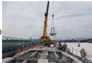
切断した床版を撤去
