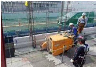
老朽化した床版を切断
