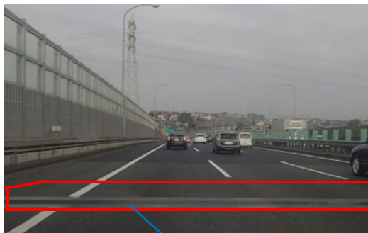
継目(伸縮装置)
