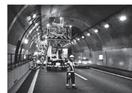
＜トンネル内の点検＞
