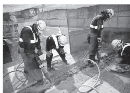
＜橋のつなぎ目の取替え＞
