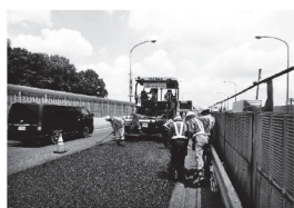
＜傷んだ路面の補修＞
