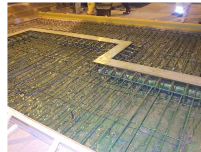
②鉄筋組立
