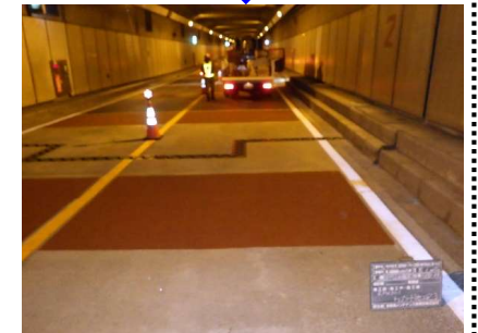
④滑り止め舗装・区画線
