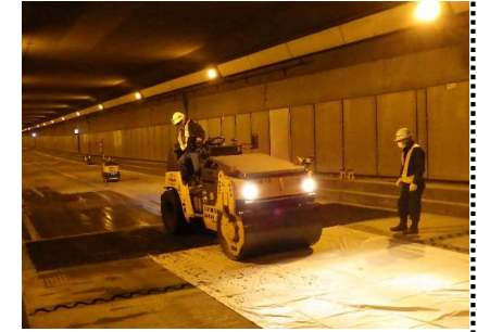
③舗装打設
